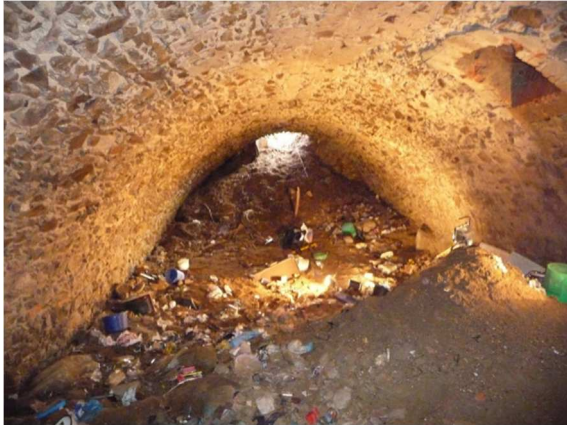
Abbildung 2: Ungenutztes Gewölbe im 2. Kellergeschoß eines „Belvedere“, das Gebäude wurde in den 1970er Jahren abgerissen und das 1. Kellergeschoß mit Schrott, Müll und Schutt verfüllt; die Belastung des Gewölbes hat sich vervielfacht, eindringendes Wasser hat den Mörtel der hochbeanspruchten Mittelwand in Teilbereichen zerstört, der Einsturz droht; eine künftige Nutzung ist aufgrund der Zugänglichkeit schwierig, der Vorschlag für den Erhalt ohne konkrete Nutzung wurde bisher nicht umgesetzt
