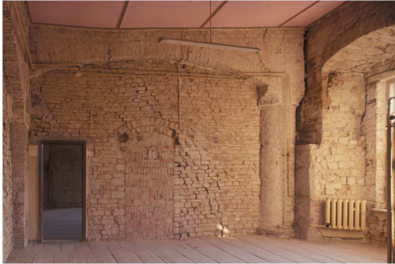
Abbildung 5: Studentische Übung: Bogen mit nachträglicher Untermauerung; Die Außenwand (rechts) kippt geringfügig nach außen, die Spannweite des Bogens wird größer, er setzt sich in der Mitte auf die Untermauerung ab. Deutlich neben dem Scheitel entstehen auf der Unterseite klaffende Fugen im Bogenmauerwerk. Der Schadensmechanismus wird rechnerisch mit einem Finite-Elemente-Modell nachvollzogen.
