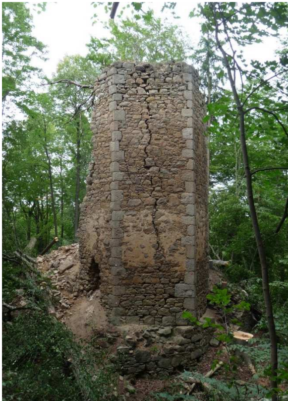
Abbildung 1: Burgruine Karlstein bei Regenstauf: Berechnungen legen nahe, dass neben Verwitterung ein Brandereignis zu den vertikalen Rissen auf allen Seiten des Turmes geführt haben; der Bergfried wurde als lokales Baudenkmal im Jahr 2014 instandgesetzt
